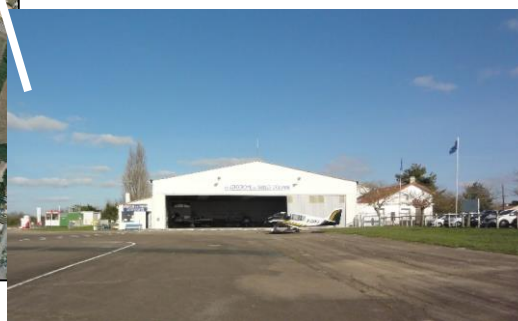
Hangar utilisé par l'aéroclub de la Vendée
